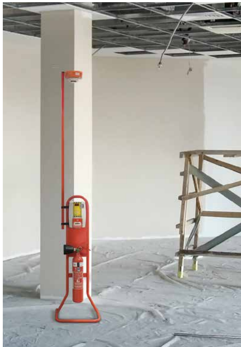
Mise en situation
