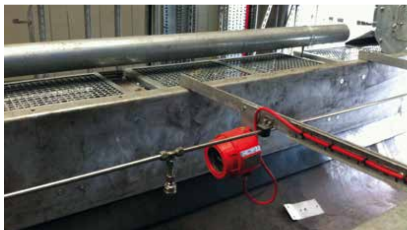
Mise en situation
